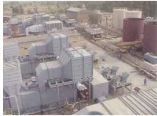
صورة شاملة لمنشأة التوليد الكهربائي وحدة رقم 2 ووحدة 3
