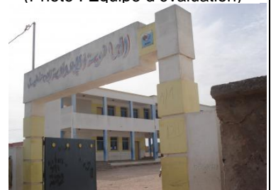
Collège construit dans la province d'El Jadida (Photo : Equipe d'évaluation)
