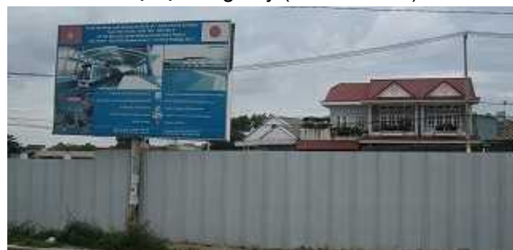
Bảng giới thiệu công trường thi công tuyến số 1 đường sắt đô thị (Hồ Chí Minh)
