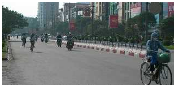
Xây dựng mạng giao thông Thành phố Hà Nội (Cải tạo đường Trần Khát Chân)
