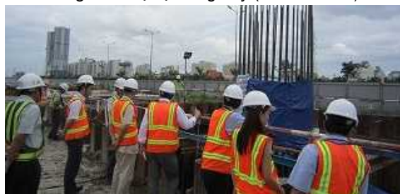
Thị sát công trường thi công tuyến số 1 đường sắt đô thị (Hồ Chí Minh)
