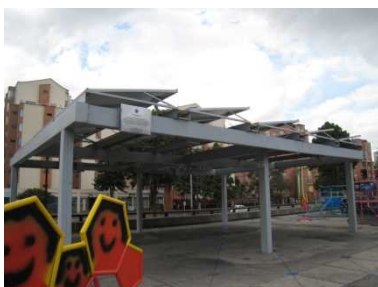
Existen 40 paneles solares provistos por Japón que se exhiben junto con otras muestras fuera del museo.
