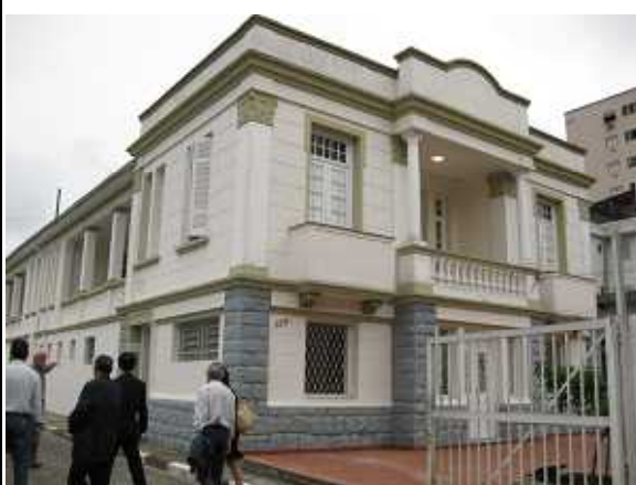
Edifício restaurado através da "Restauração da Escola Japonesa de Santos" (Outorga de Auxílio Cultural do Programa de Assistência para Projetos Comunitários)
