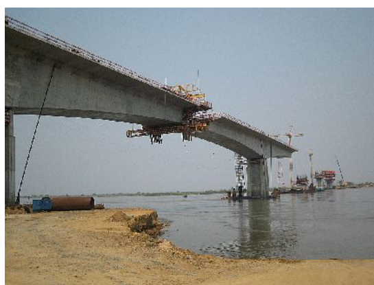
Ponte do Zambeze (em construção)
