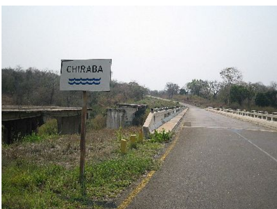
Ponte do Chiraba na Rota 225
