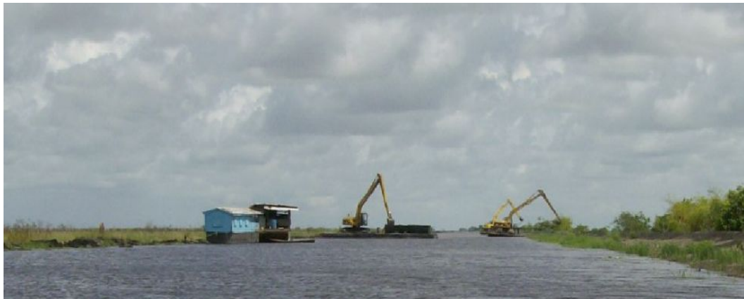
東デメララ貯水池
