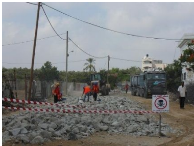
不発弾及び瓦礫除去作業
