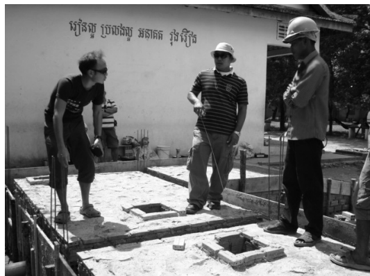
建設現場をチェック中
