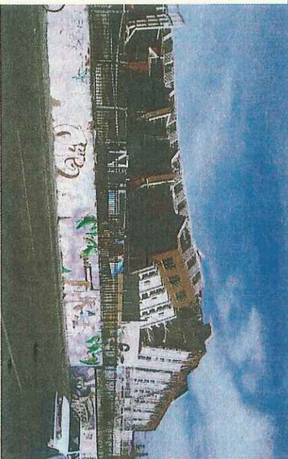
コンセプシオン市の倒壊した15階マンション
