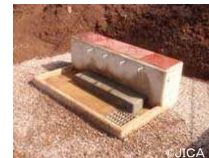
地方給水計画で作られた公共水栓。三次にわたって総額約30億円の無償資金協力を実施。
