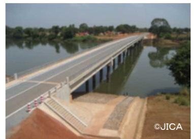
建設されたバフィン橋
