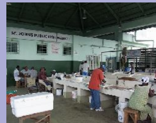
アンティグア・バーブーダ 「セントジョーンズ水揚・流通施設建設計画」
