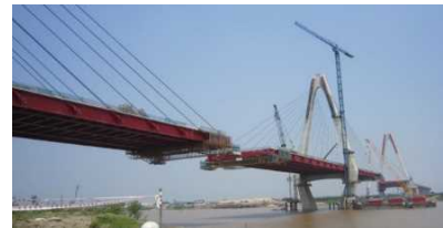
建設中のニャットン橋
