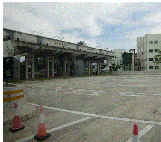
南部ハイウェイは、コロンボ郊外から観光地として有名な南部都市ゴールまでを結ぶ。スリランカ初の高速道路であるため、運営者及び利用者の安全に対する意識向上が重要とされる。
