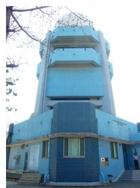
コックスバザールレーダー塔 (2011 年 10 月撮影)
