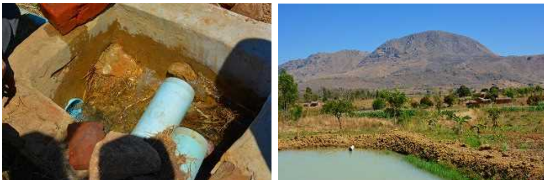
写真 3-19 かんがい設備(左:かんがい水の分配設備, 右:溜池)
