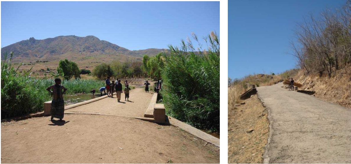
写真 3-25 舗装されたリンジジ橋(Linjidzi Bridge) (左)と道路(右)
