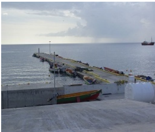
栈橋(接岸施設)
