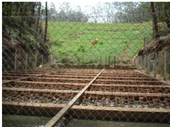
ヌワラ・エリヤ衛生埋立処分場(汚水処理部分)視察
