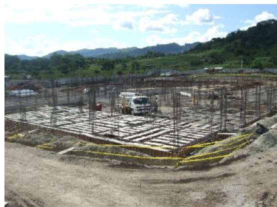
ボアコ病院建設計画、建設現場の視察
