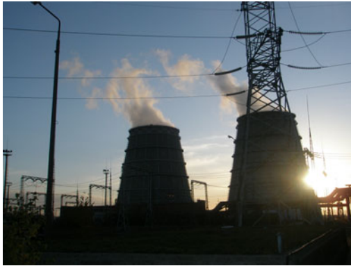
第4火力発電所
