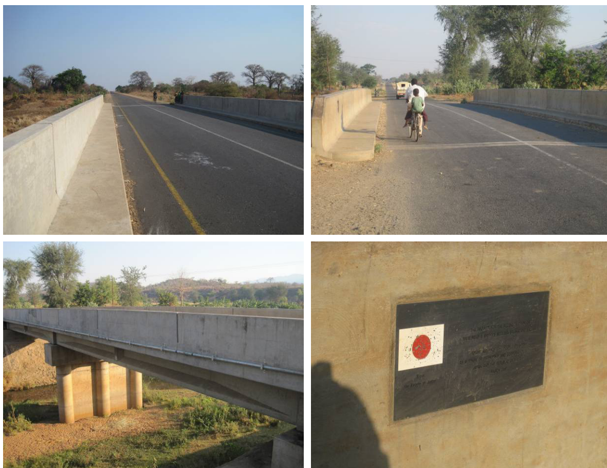
図 4-22 写真:「バラカーサリマ間国道五号線橋りょう架け替え計画」により整備された橋りょう
