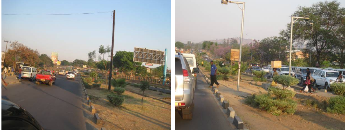
図 4-23 写真:「ブランタイヤ市道路網整備計画」の一環として整備されている道路
