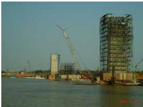
橋げたの建設
