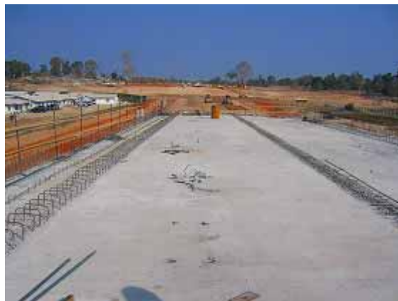
アプローチと通関施設等の建設用地
