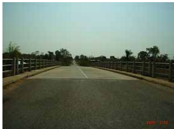
改修された橋
