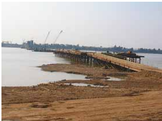
基礎工事現場
