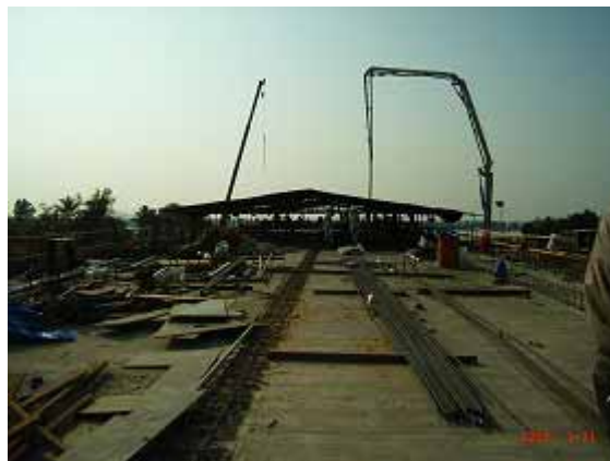
アプローチの建設
