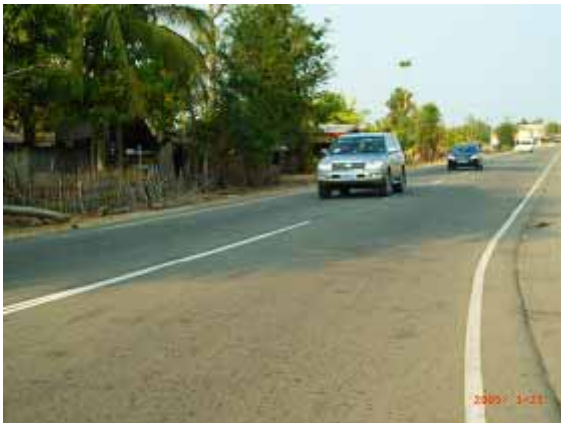
国道 9 号線 (Seno 付近)
