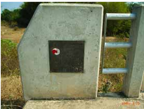
第二次国道 13 号線橋梁改修計画
