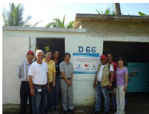
撮影:評価チーム 設置された水中ポンプ場
