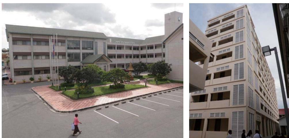
写真 4-6 TSMC で日本が建設した校舎(左)とカンボジア政府が建設した高層棟(右)
