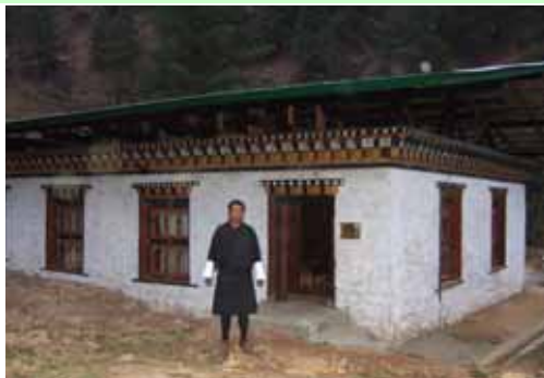
パイロットプロジェクトで建設された コミュニティホール
