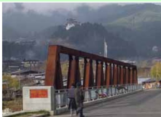
チャムカール橋（ジャカル）
