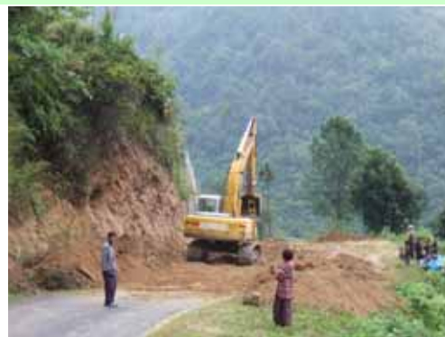
崩れた土砂を除去するショベルカー
