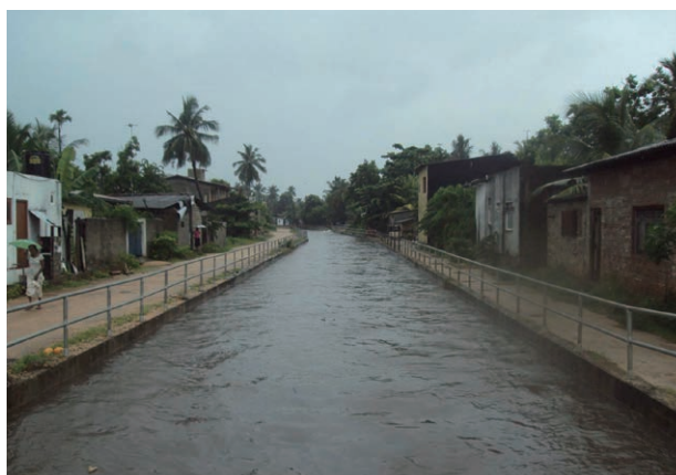
スリランカ ルナワ湖周辺生活環境改善事業 事業実施後の排水路
