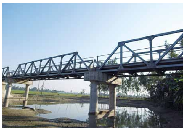
地方道路簡易橋計画（シラジゴンジ県に建設された橋）（バングラデシュ）
