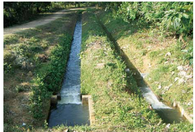
フラウェ川左岸灌漑改修拡張事業によって整備された稲作・畑作別の水路（スリランカ）
