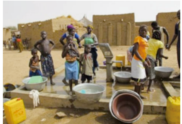
カイ・セグー・モプチ地域給水計画で設置された人力ポンプ付き深井戸（マリ）
