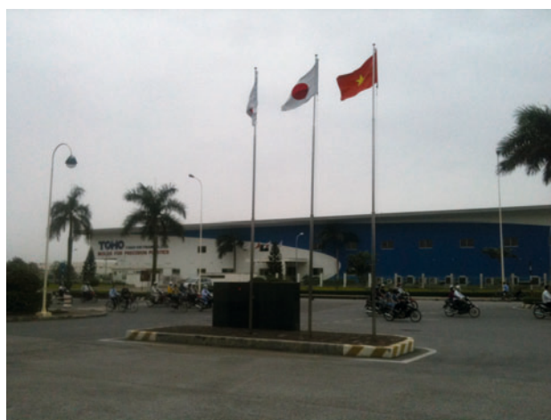
ベトナム タンロン工業団地
