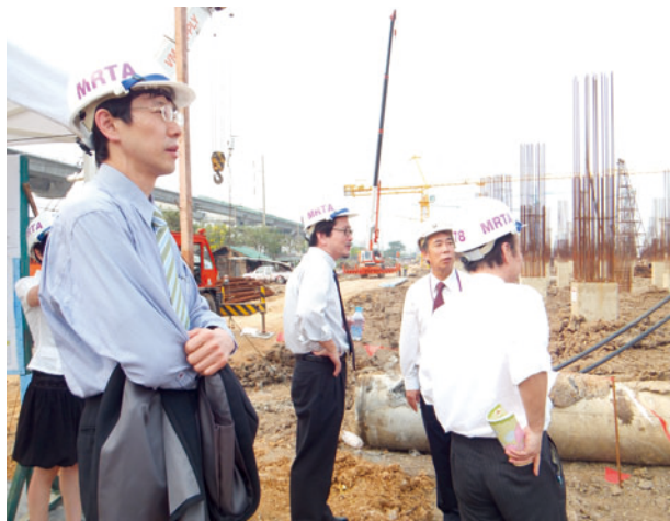
日本の円借款により整備が進められているバンコク都市鉄道の「パープルライン」の建設現場視察
