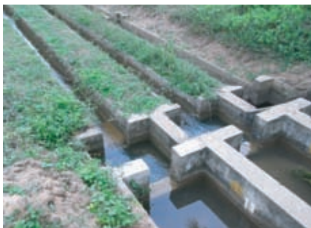
スリランカ・ワラウェ川左岸かんがい改修拡張事業によって整備された水路
