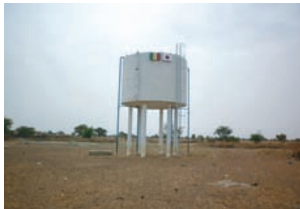
完成した地方村落給水施設
