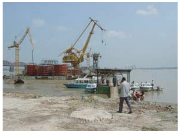
パクシー橋建設による輸送網の整備
