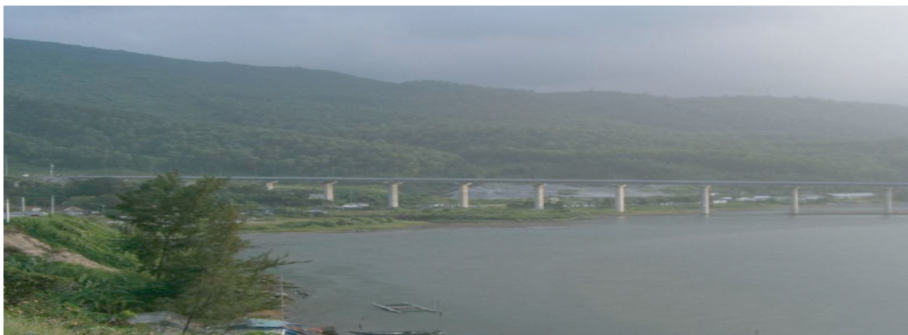
ランコー岬からハイヴァン・トンネルへのアプローチ道路・橋梁（有償）
