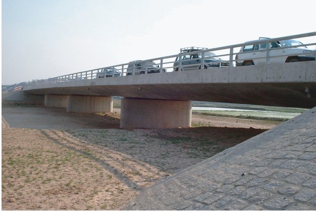
無償資金協力により建設された国道七号線バイパス道路
