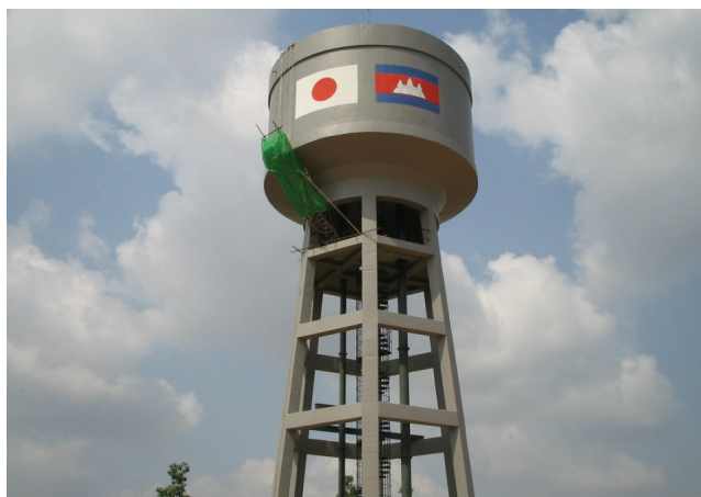
無償資金協力で建設された水道塔（シェムリアップ上水道）
