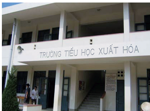
バクカン省Xuat Hoa Primary School (北部山岳地域初等学校建設計画によって建設された小学校) 外観
