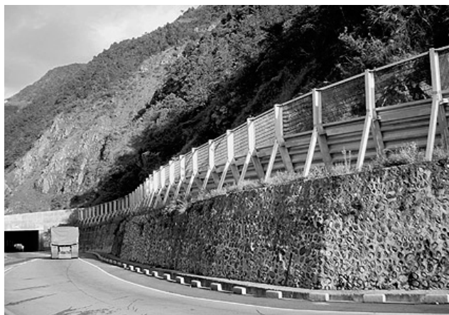
落石防護フェンスが張られたロザリオ～プゴ～バギオ道路
