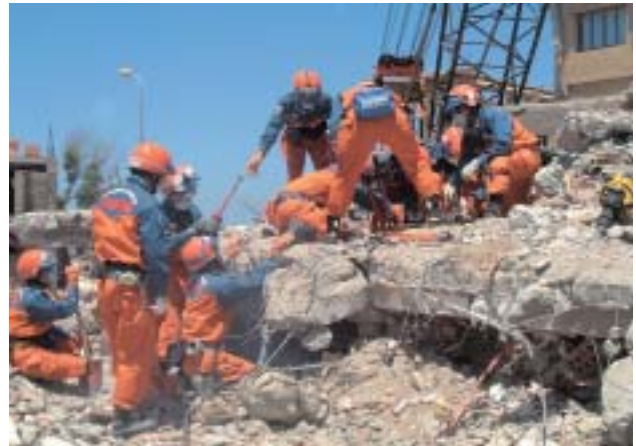
JDR救助チーム(アルジェリア地震災害) 倒壊ホテル現場での救助作業
