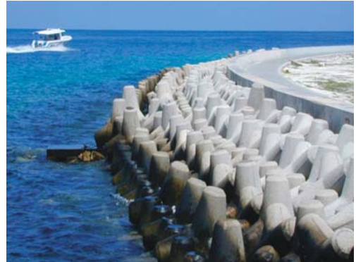
マレ島の周囲に建設された護岸
