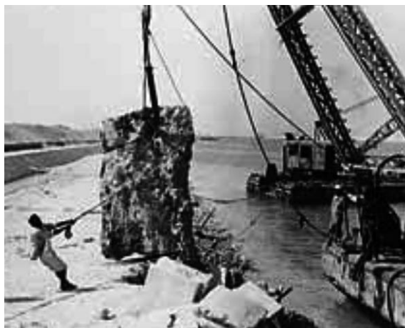
岩盤撤去作業
