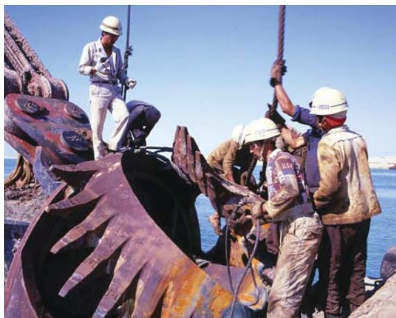
作業に使うカッターヘッドの修理の様子
