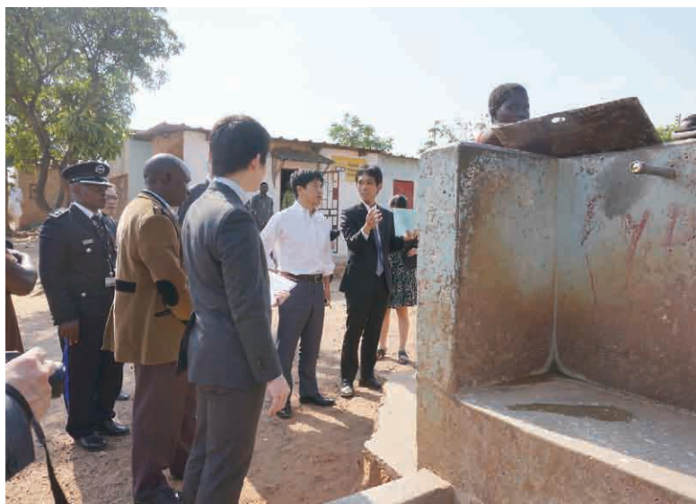
日本の無償資金協力により整備されたザンビアのンゴンベ・コンパウンド給水施設を視察する中根一幸外務大臣政務官
