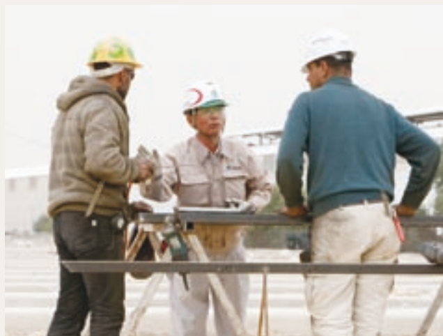
現地作業員を指導する日本のサブコントラクターの現場責任者(写真:久野真一/JICA)
