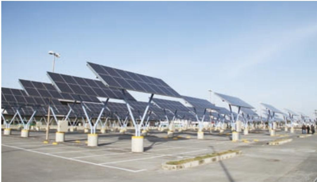
アフガニスタンのカブール国際空港施設内において系統連系型太陽光発電システムを設置。本発電で国際線ターミナルの電力需要の約35%を賄う
