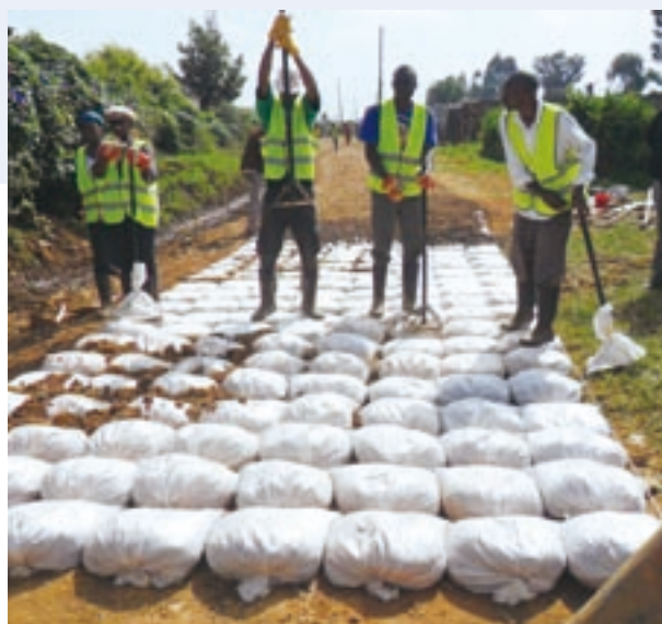
土の工法の訓練を受けた地元住民により、道が生まれ変わる(写真:道普請人)
