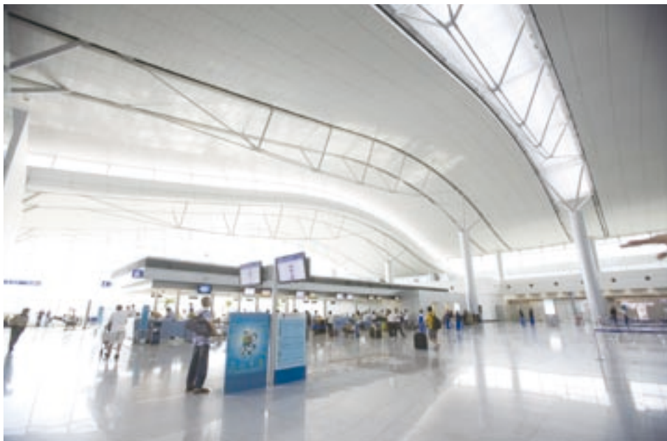
ベトナム・ホーチミン市に円借款により建設されたタンソンニャット国際空港ターミナル(写真：久野真一/JICA)
