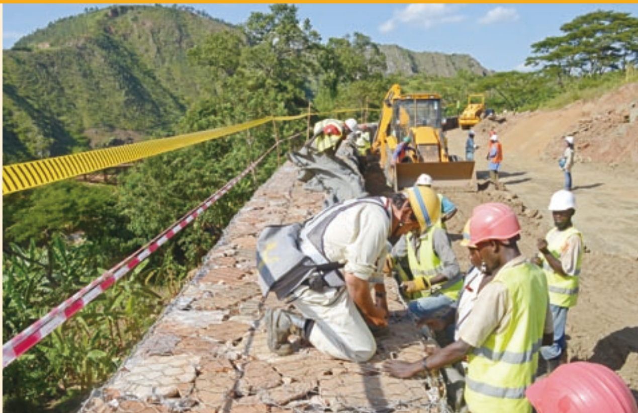
タンザニアとルワンダをつなぐルスモ国際橋で作業指導する日本人技師 (写真: 久野武志/JICA)
