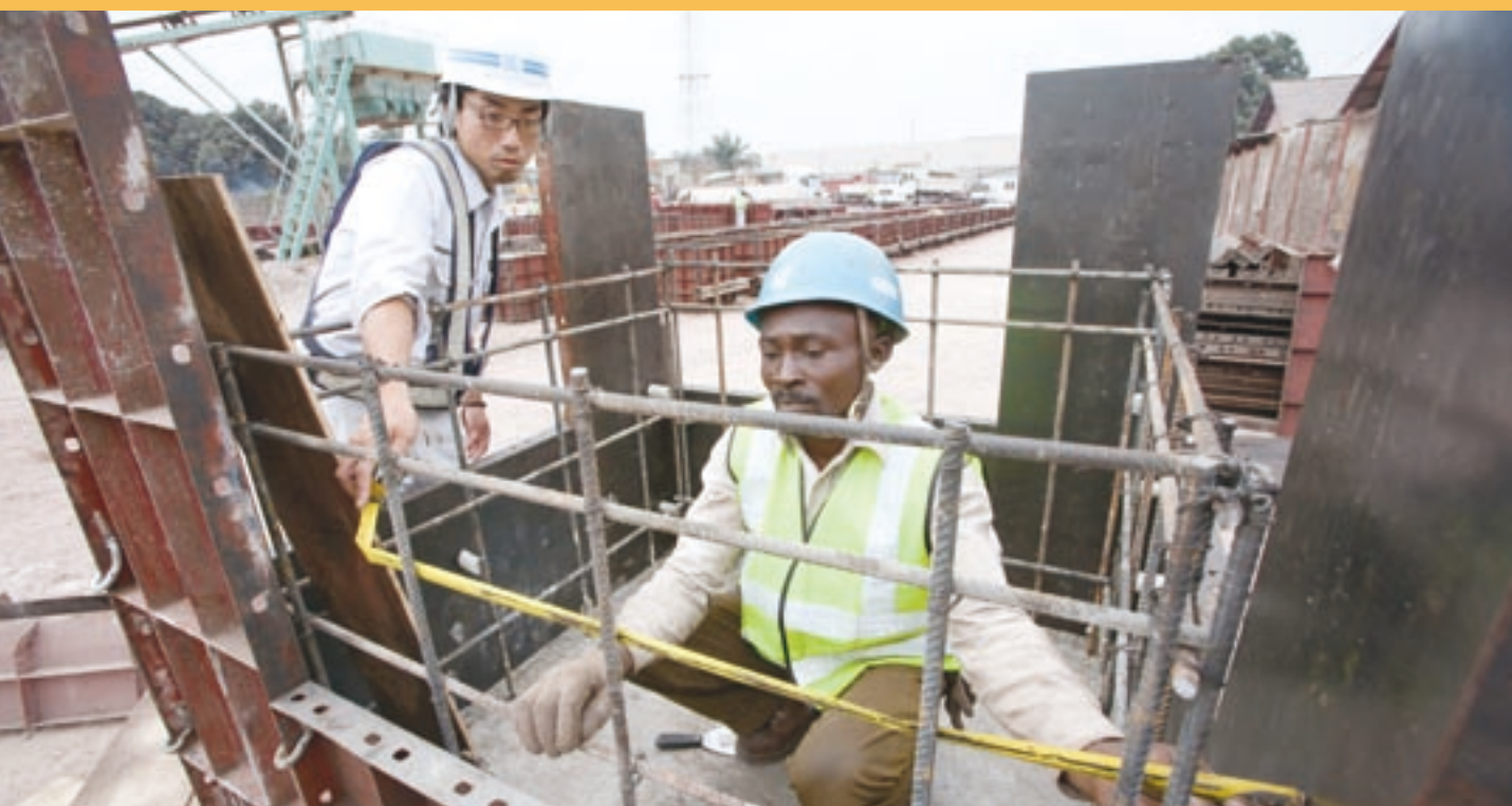
コンゴ民主共和国で、渋滞著しい主要道路の整備・拡張を行う日本技術者と現地スタッフ (写真：久野真一/JICA)
