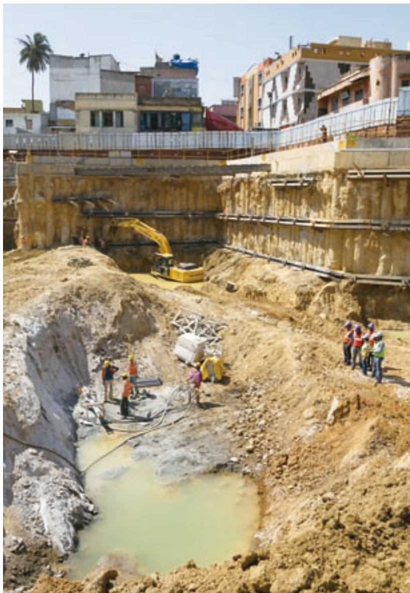
インド・バンガロールの地下鉄工事現場。建造物が密集する中心街に位置するチップペット駅での掘削工事 (写真：藤田修平)
