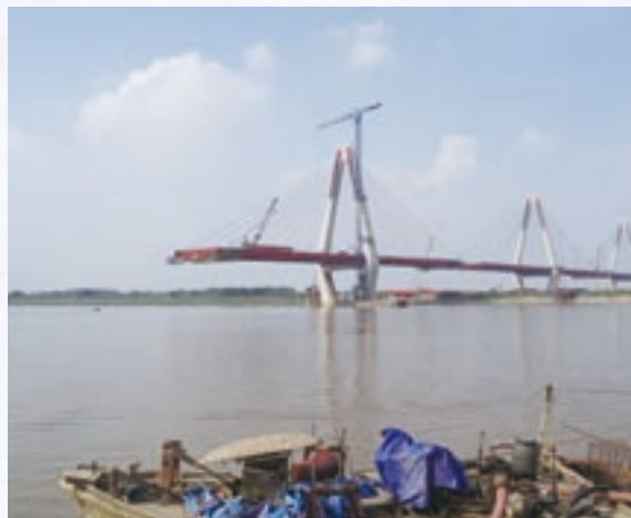
ホン河下流から眺める建設中のニャッタン橋(写真: 梶村雄佑)
