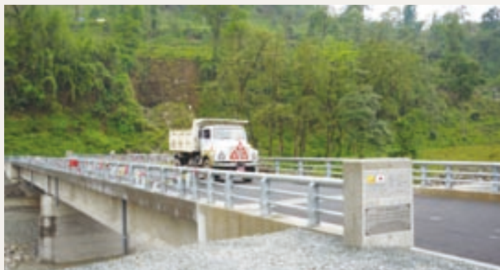
架け替えられた耐久性の高い橋梁(写真: JICA)
