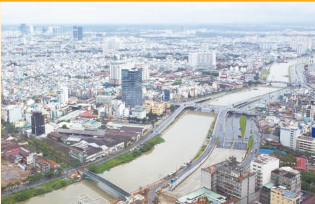
ベトナムで建設中のサイゴン東西ハイウェイのトンネルを眼下に望むホーチミン市街 (写真：永武ひかる/JICA)
