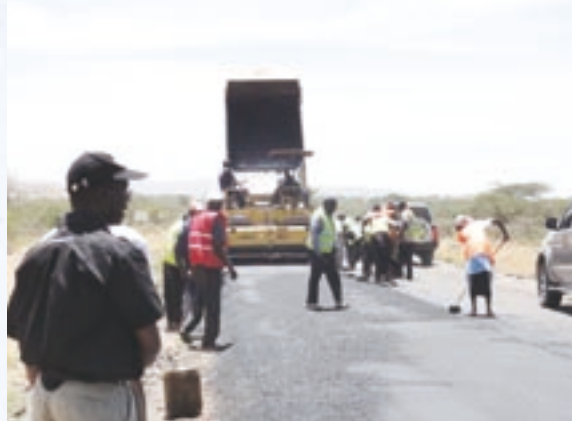
サバナを通る道路での舗装補修工事の現場(写真:西林素彦)
