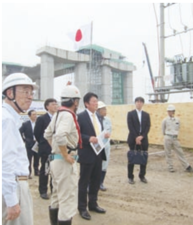
ベトナムのニャットタン橋建設工事を視察する松山政司前外務副大臣
