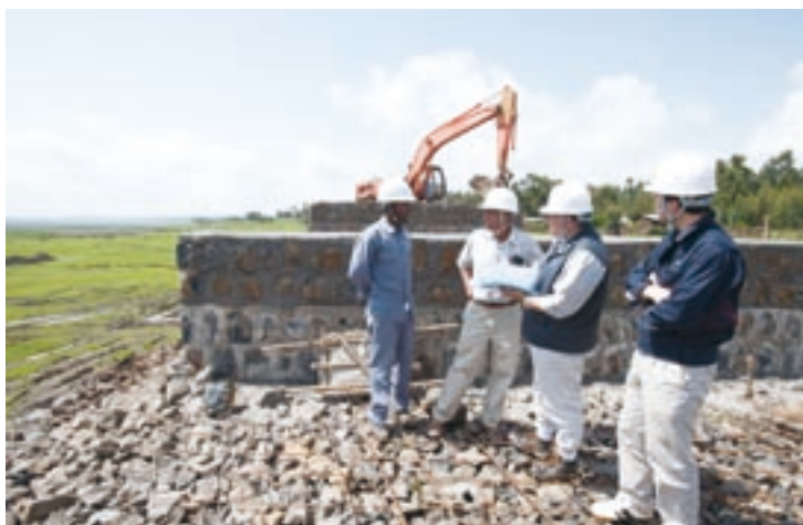
エチオピア第四次幹線道路改修計画で工事キャンプを建設中の日本人技術者 (写真：今村健志朗/JICA)
