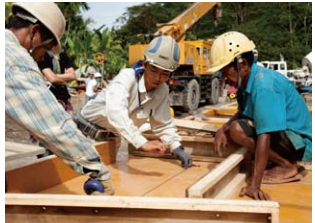
東ティモールのベモス川上流にある取水堰 しゅすいせき で働く日本人大工と流域住民スタッフ (写真：久野真一/JICA)
