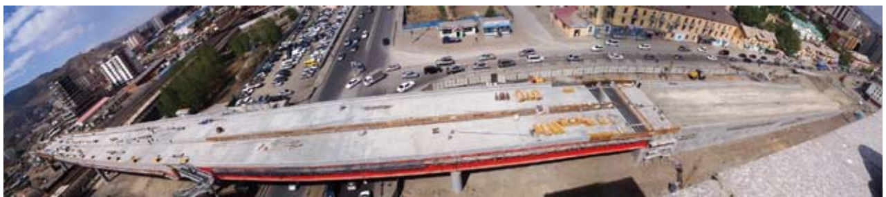
鉄道をまたいで建設中の太陽橋 (写真：JFEエンジニアリング)
