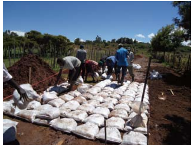
道普請人の工法による土のう補修は現地住民自らが容易に行うことができる (ケニアのリフトバレー州で) (写真：道普請人)
