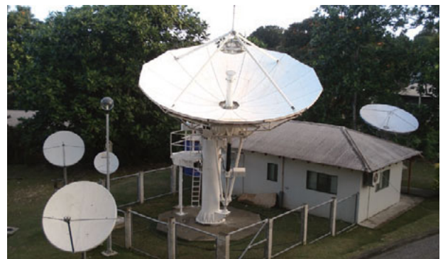
フィジー「南太平洋大学ICTキャパシティ開発プロジェクト」遠隔教育ネットワーク (USPNet) を構築する衛星通信地球局。ここから大洋州地域島嶼国12か国の遠隔キャンパス・学習センターに、遠隔教育プログラムが提供されている (写真提供: プラマニク・カデル・博)
