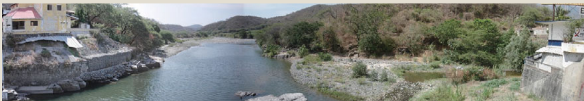
着工前の状況(2010年10月時点) 既設マカラ橋から下流側を望む。向かって左側がペルー、右側がエクアドル(写真提供:日本工営)
