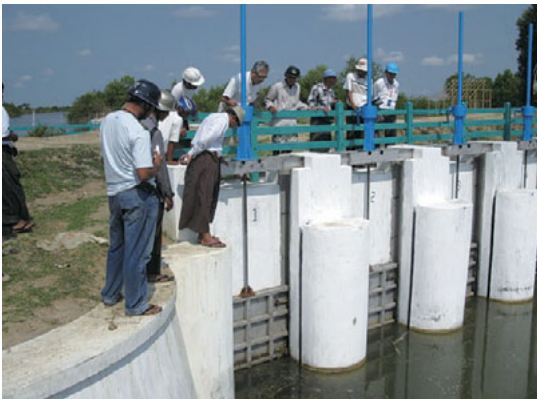
ミャンマー「サイクロンナルギス被災地域における農業生産及び農村緊急復興のための農地保全プロジェクト」輪中水門ゲート修復後に、水門ゲートの状態・機能を確認 (写真提供: JICA)
