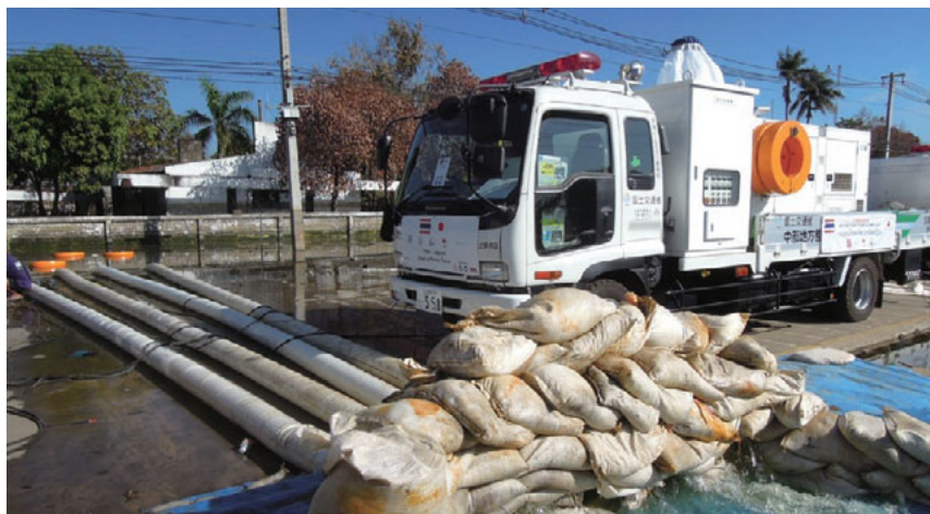
タイの工業団地で作業にあたる日本の排水ポンプ車。1台で毎分30m 3 の排水能力を持つ(写真提供:JICA)
