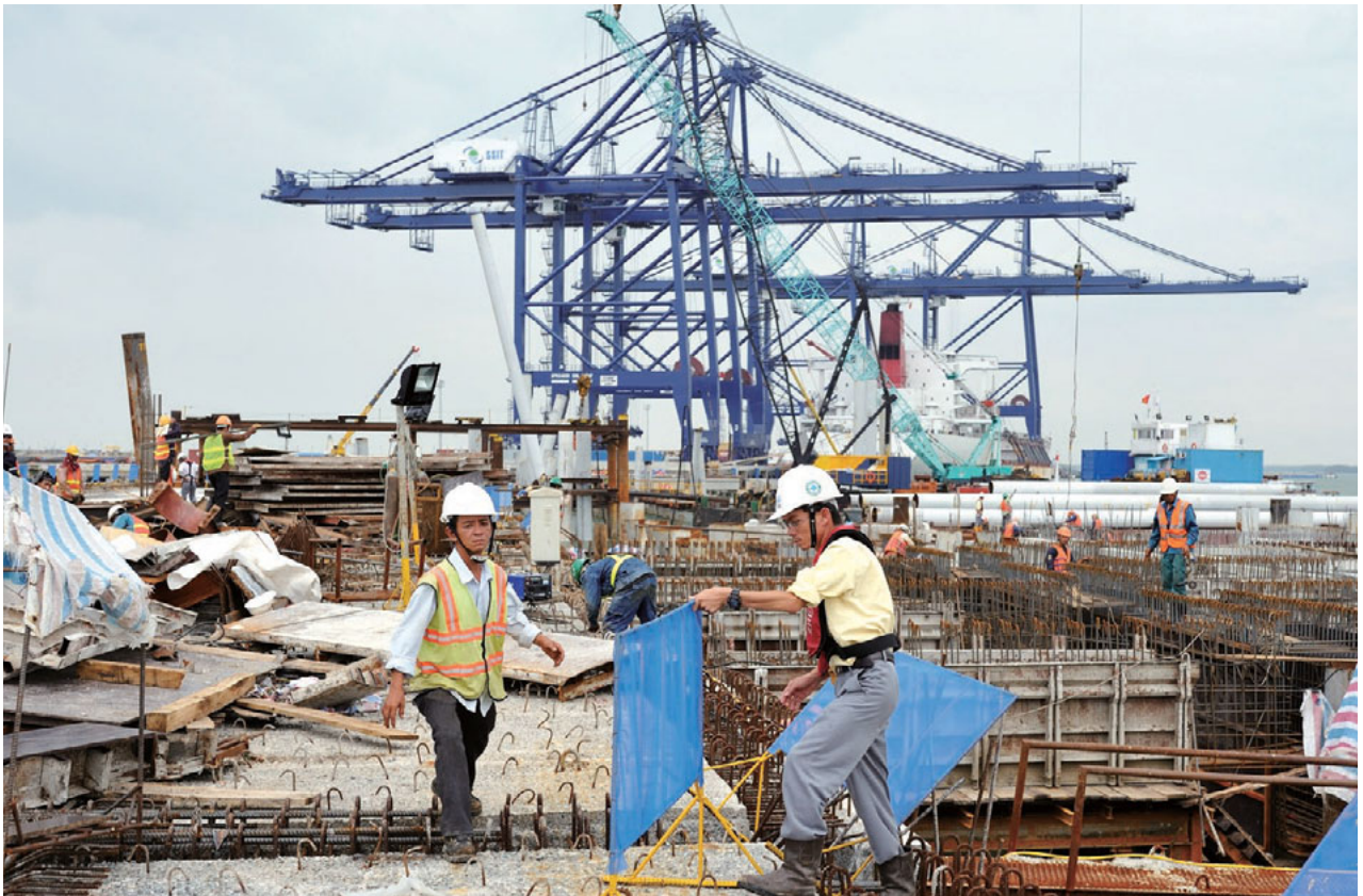
ベトナム「カimeップ・チーバイ国際港開発計画」カimeップ港の建設現場（写真提供：佐藤浩治/JICA）
