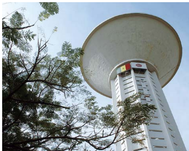
セネガルの給水塔(写真提供: 今村健志郎 / JICA)
